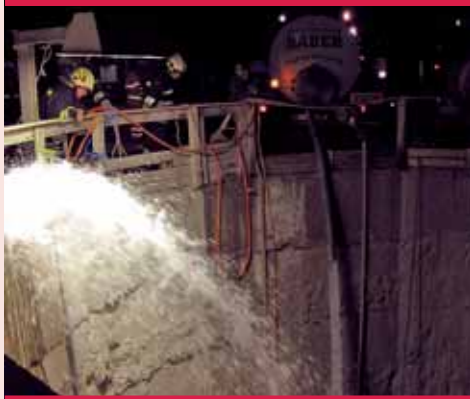
7. 4. 2009: Fluten des Rettungsschachtes – Hilfeleistung BEG.
